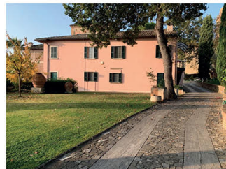
Ingresso lato posteriore
